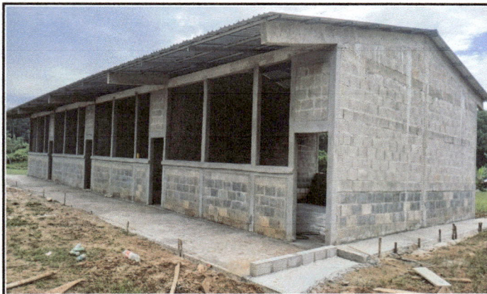
Foto 2: Se le dio remozamiento correctivo a las ventanas de las cuatro aulas de la escuela con el apoyo de los programas de apoyo.
