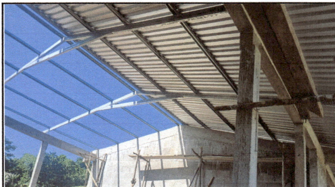
Foto 4: De esta manera se visualiza las mejoras de la estructura metalica del techo de las aulas de la escuela.
