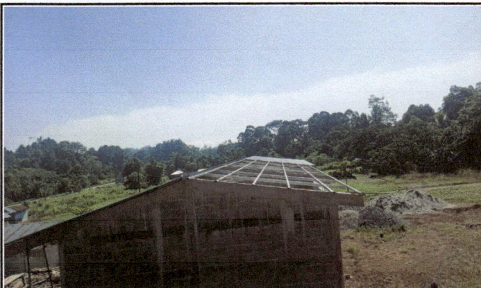
Foto1: Avance del cambio de la estructura metalica del techo de las aulas priorizadas, gracias al apoyo del programa de remozamiento.
