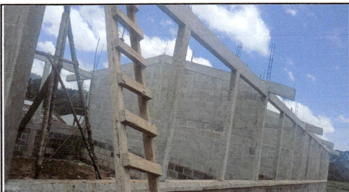
Foto 3: Avance de remozamiento de las ventanas de las aulas priorizadas de la escuela con apoyo del programa de mejoramiento de edificios publicos.
